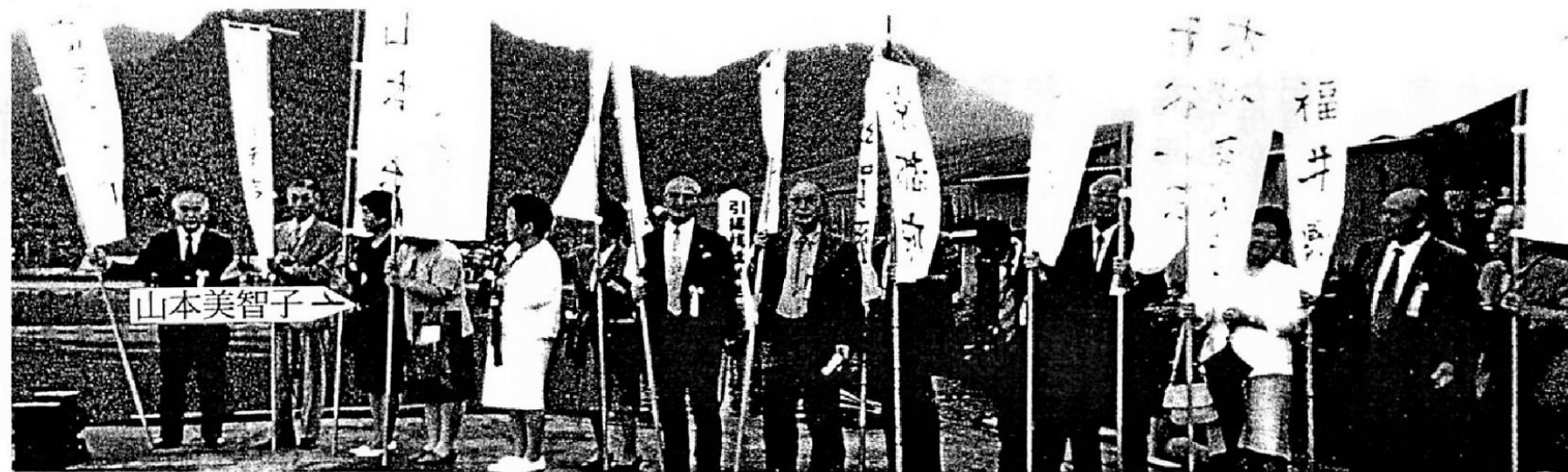
当時を再現し引揚者を待つくたいら栈橋>撮影 橋詰
