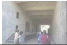
写真3 火薬庫は頑丈な造り
