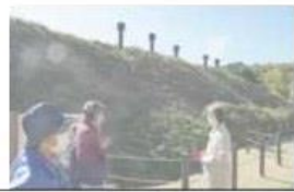
写真2 旧第一火薬庫の土裏で覆う
